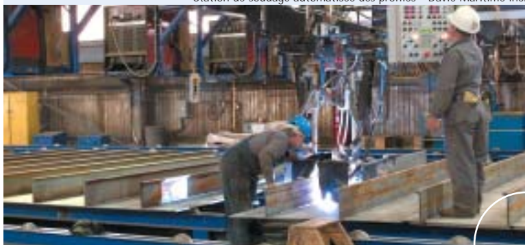
Station de soudage automatisée des profilés - Davie Maritime inc.
