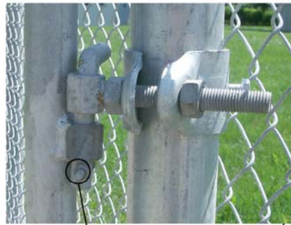
CROCHET PERFORÉ A L'EXTRÉMITÉ POUR INSERTION D'UN BARRURE DE 25mmØ.
