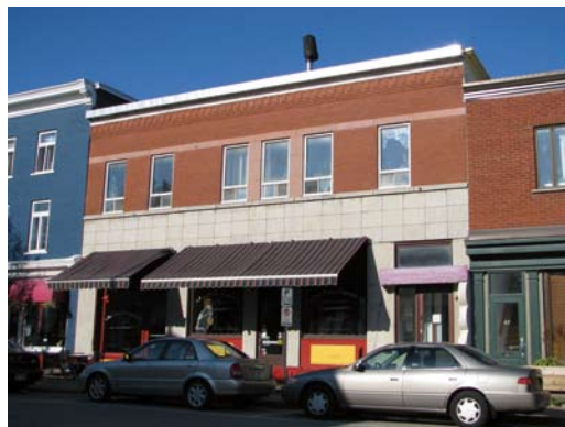
6 Photographie récente de l'immeuble après la réalisation des travaux qui ont permis de mettre en valeur le bâtiment dans la foulée du règlement sur les PIIA alors en vigueur dans le Vieux-Lévis.
