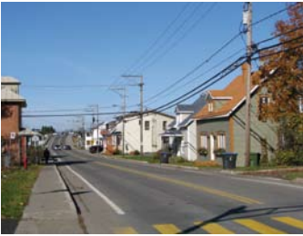
3 Maison construite vers 1870, rue des Pionniers (secteur Saint-Nicolas).
