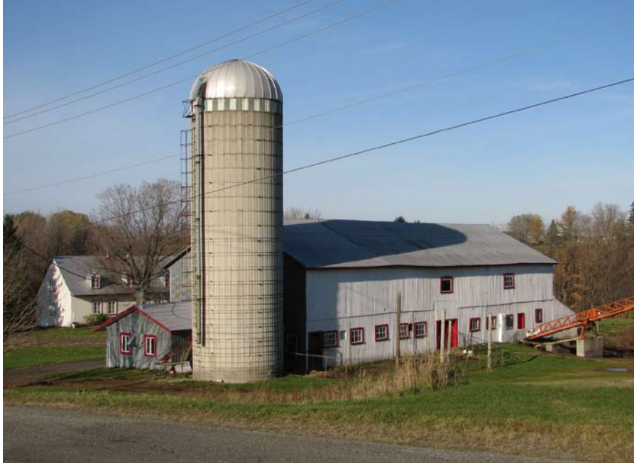
5 Ensemble agricole situé sur le chemin Terrebonne (secteur Saint-Jean-Chrysostome).
