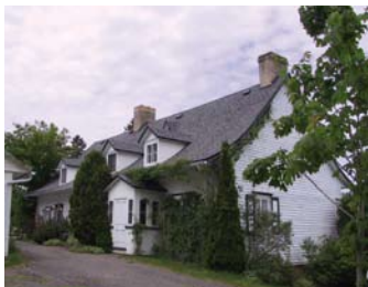
Vue arrière de la maison Filteau, érigée vers 1720, rue des Pionniers (secteur Saint-Nicolas).
