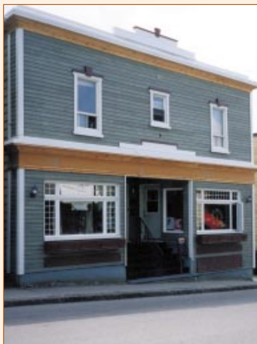
RÉNOVATION : Cette bâtisse abrite le restaurant De Vinci et la boutique Frivolités et Dentelles. La partie avant de l'immeuble date du siècle dernier, tandis que la partie arrière date des années 1930. Lors de la rénovation, le parement extérieur a été changé et des corniches ont été ajoutées. Pour le propriétaire, l'aspect « garniture » est très important. Selon lui, la qualité du bâtiment historique se distingue, entre autres, par ses corniches.
