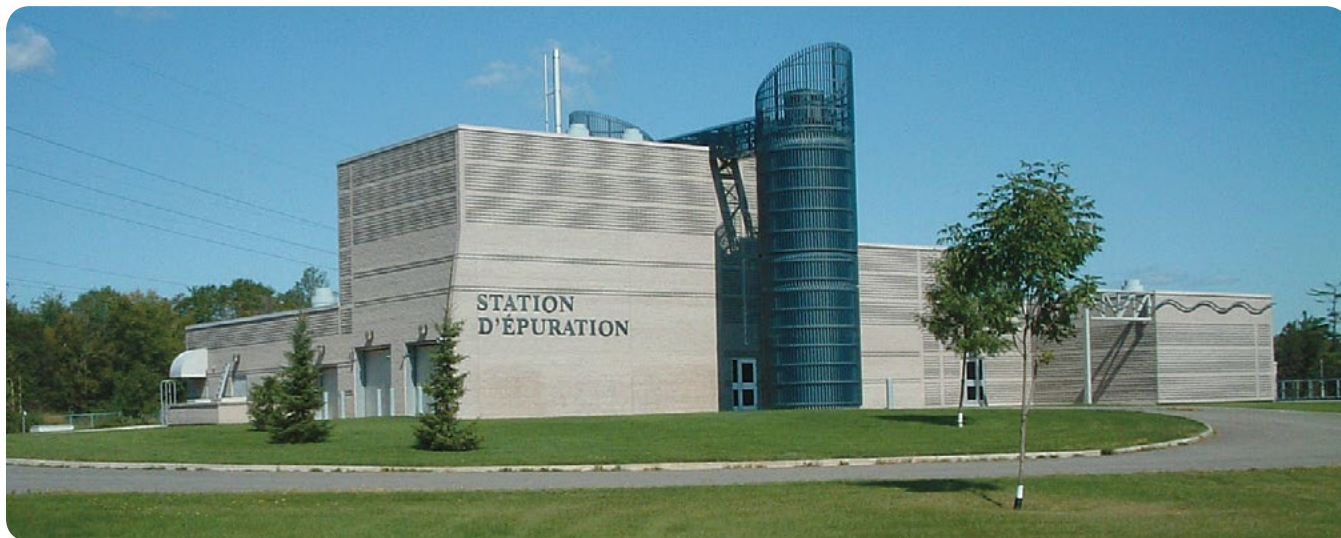
Figure C – Usine de traitement des eaux usées, quartier Saint-Nicolas
