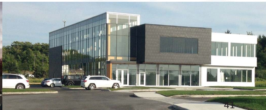
Nouveau bâtiment de Lesva
