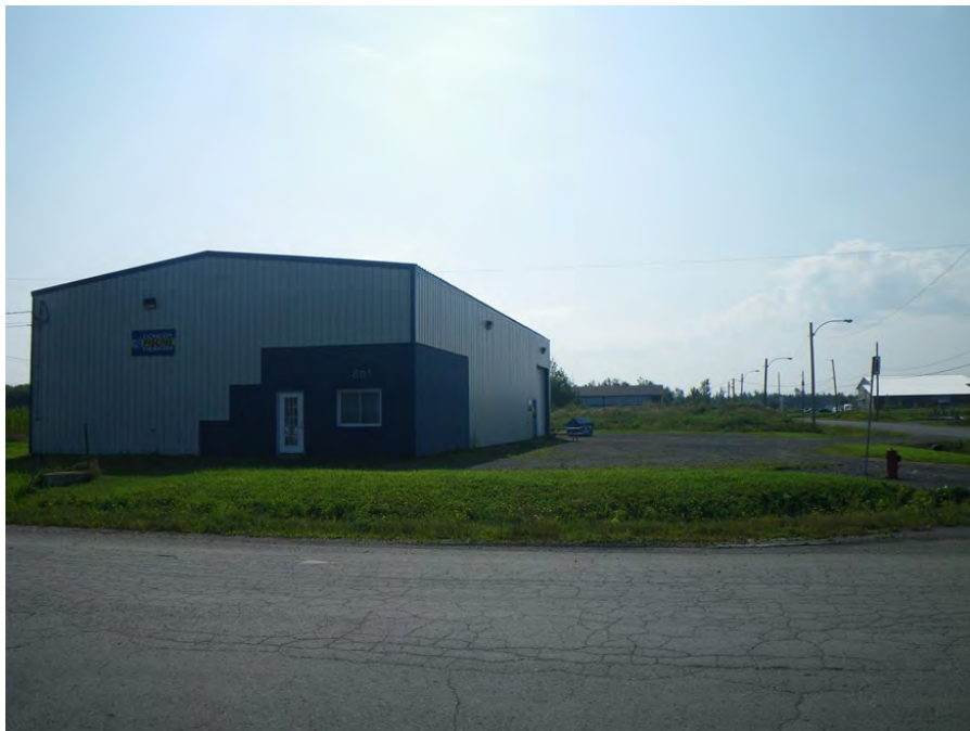
Photo 6 : Secteur industriel à l'est du site
