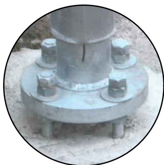
RONDELLE 178mmØ 22.22mm ÉP. AVEC 4 TROUS 19mmØ
