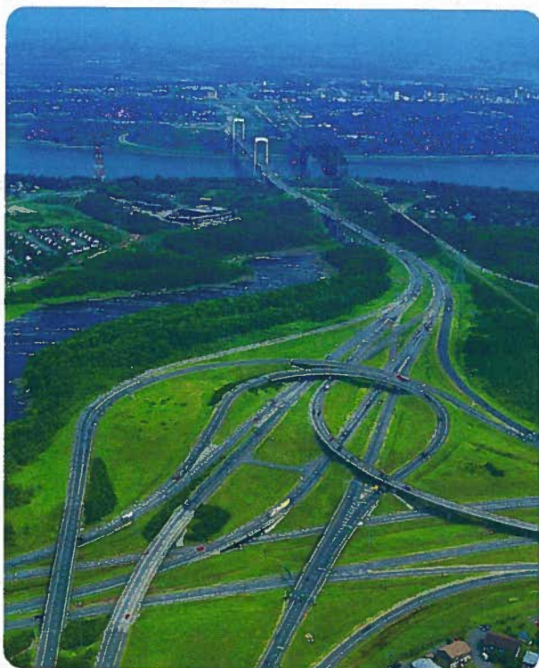
Figure 24 Échangeurs des ponts
