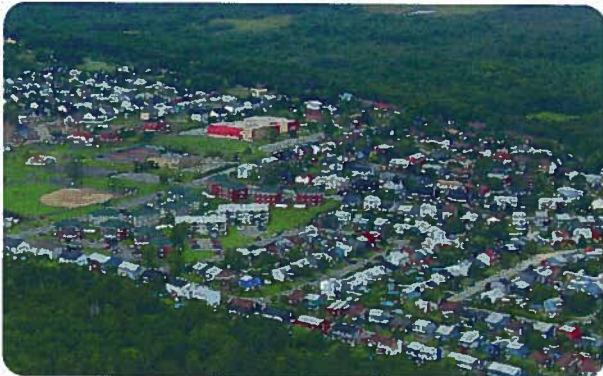
Figure 25 Vue aérienne, quartier résidentiel, secteur Saint-Nicolas
