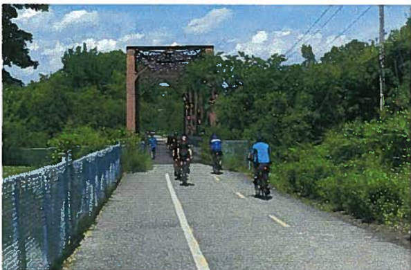
pont pour vélos et piétons au-dessus de la rivière Etchemin (parcours des Anses)
