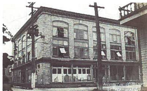
l'édifice de la BVD Company Ltd abrite aujourd'hui une coopérative d'habitation
