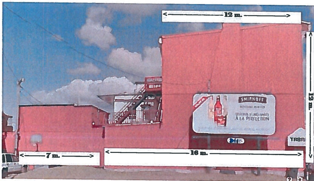
Dimension de la façade sud de l'immeuble du 80-88 Côte du Passage.
