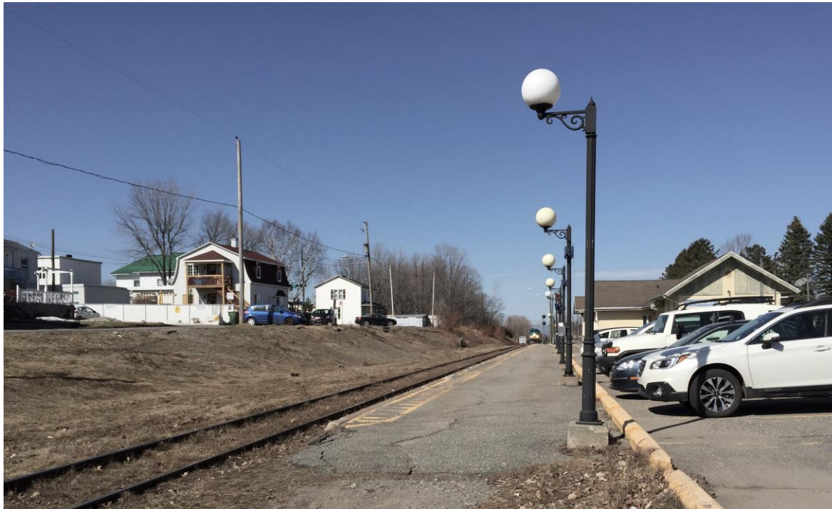
Site de la gare de Charny © Anne Carrier Architecture
