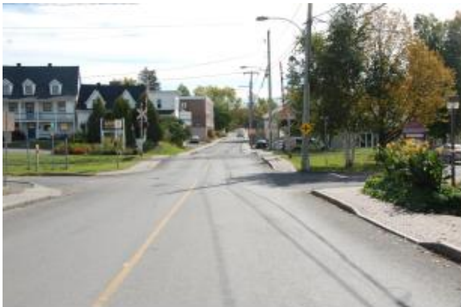
Chemin de Charny P.M. 8.16 Approche nord – Vue générale vers le sud Intersection avec la rue du Rail, est et ouest, et panneau de signal avancé proche du passage à niveau
