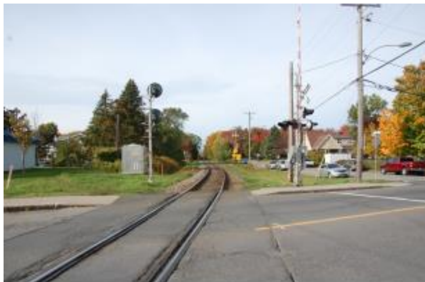
Avenue des Églises P.M. 0.58 S/D Bridge Emprise ferroviaire - Vue d'ensemble vers le nord
