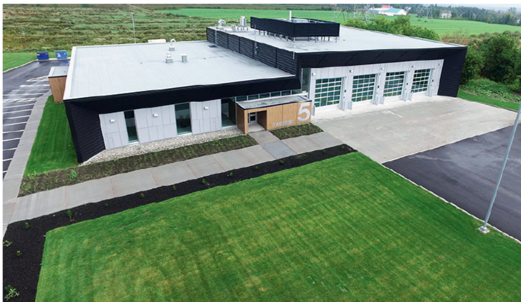
Nouvelle caserne du secteur Pintendre
