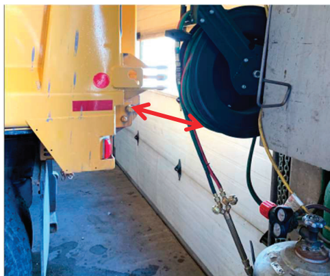
Photo 3 : Dégagement de 20 po entre l'arrière du camion et la porte de garage
