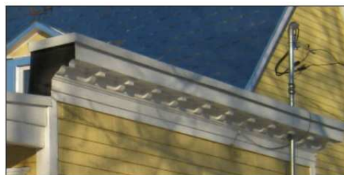
PARAPET À MODILLONS
